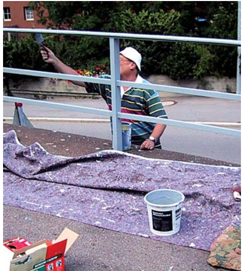
Der erste Deckanstrich wird angebracht
