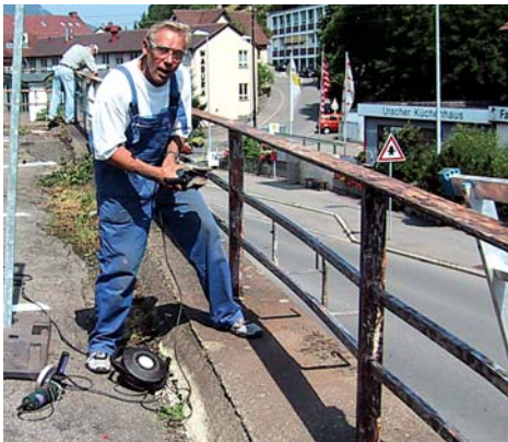
Beim abschleifen und grundieren
