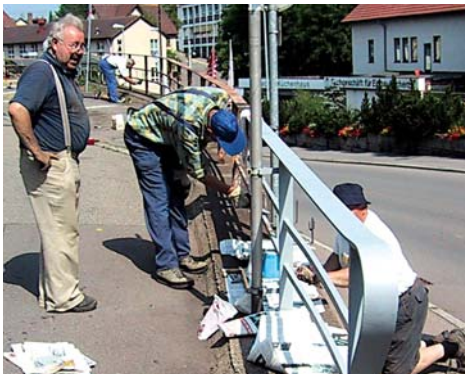
Beim abschleifen und grundieren
