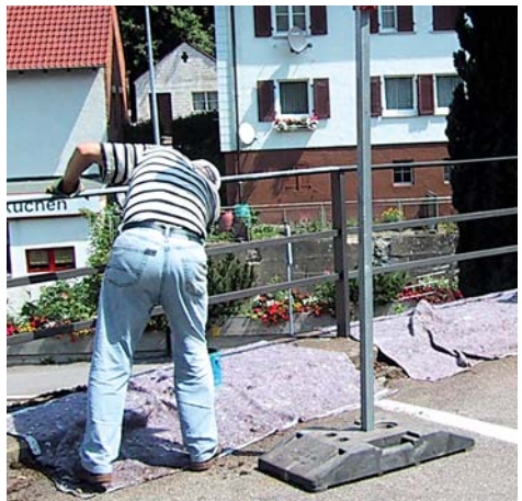
Der erste Deckanstrich wird angebracht
